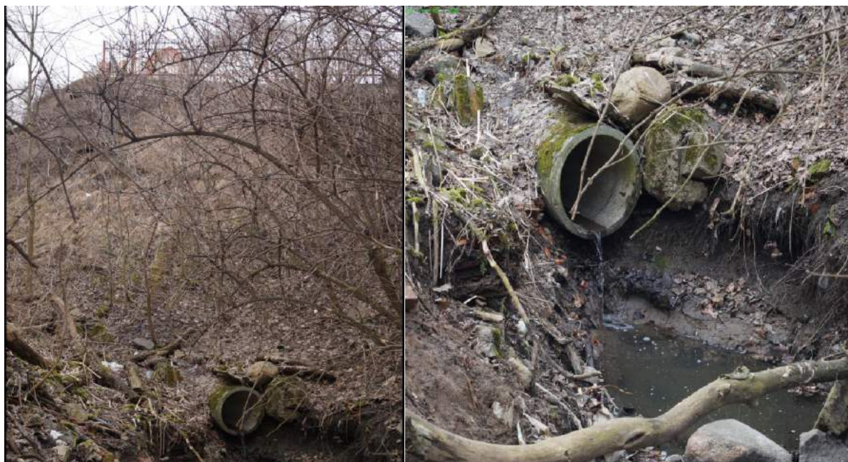
Рисунок 2.6. – Неконтролируемый выпуск КЛК в районе 4-й Октябрьский пер., д. 16 (коллектор в верхней части канавы).
